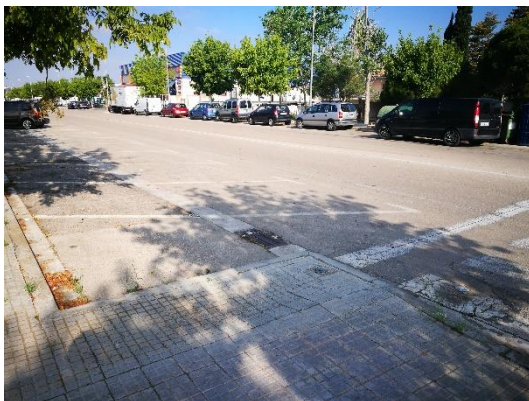
Imatge 41. Ramal oest de la rotonda, aparcament en semibateria inversa
