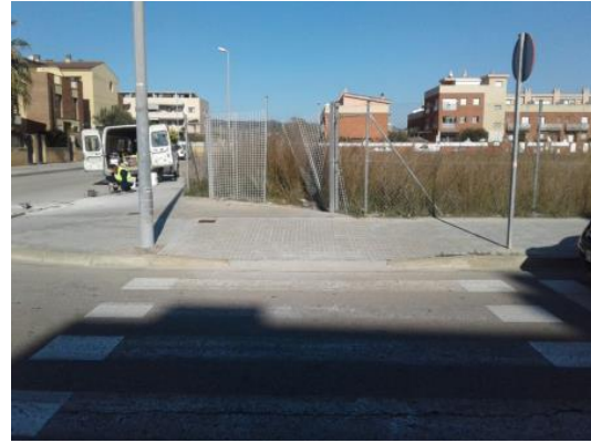
Imatge 2. Rebaix de vorera per fer accessible el pas de vianants (2018)
