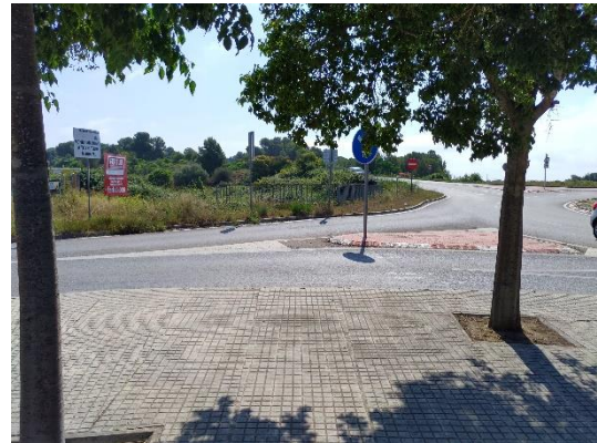
Imatge 28. Ramal nord de la rotonda de la C-31
