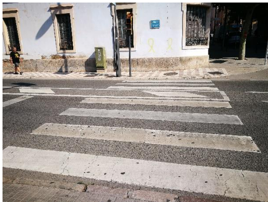
Imatge 44. Pas de vianants a la intersecció amb el passeig de Narcís Bardají
