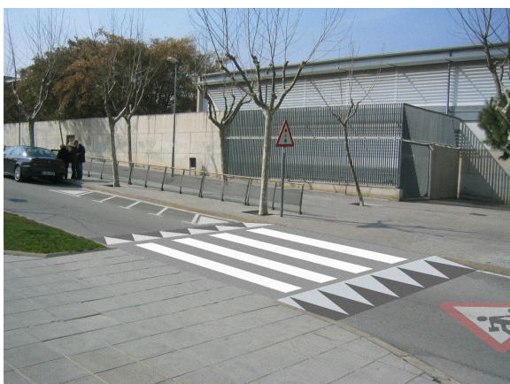
Pas de vianants elevat i senyalització horitzontal.
