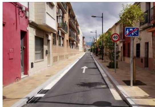
Imatge 72. Exemple d'un altre municipi de l'estrenyiment de calçada amb ampliació de vorera.
