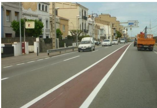
Imatge 71. Exemple de la N-II, en que s'ha establert una mitjana pintada, estrenyent els carrils de circulació.
