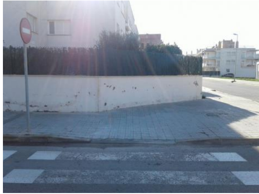
Imatge 1. Rebaix de vorera per fer accessible el pas de vianants (2018)
