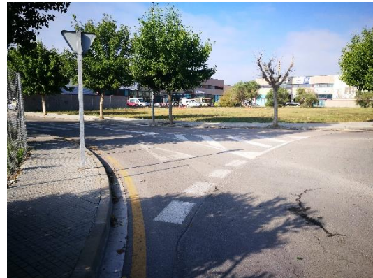
Imatge 38. Ramal sud de la rotonda
