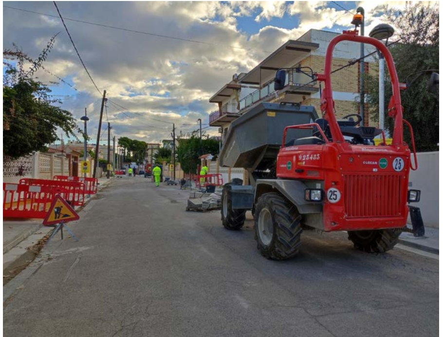
Treballadors en una de les obres de millora de l'accessibilitat dels carrers.
