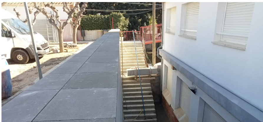
Els treballs se centren en el mur de contenció.
