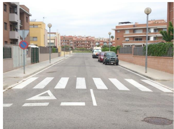
Imatge 6. Mancances en la senyalització dels carrils d'estacionament generen factors de risc a la via. En aquest cas es permet l'estacionament en calçada a un costat tot i l'evident manca d'espai, obligant els vehicles en circulació a envair el carril contrari.
