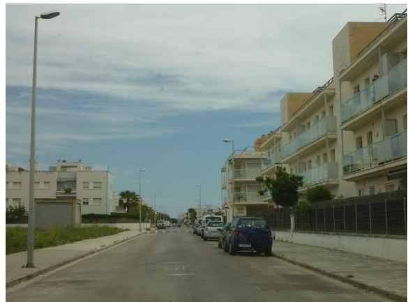
Imatge 84. Trams amb aparcament sense delimitar.
