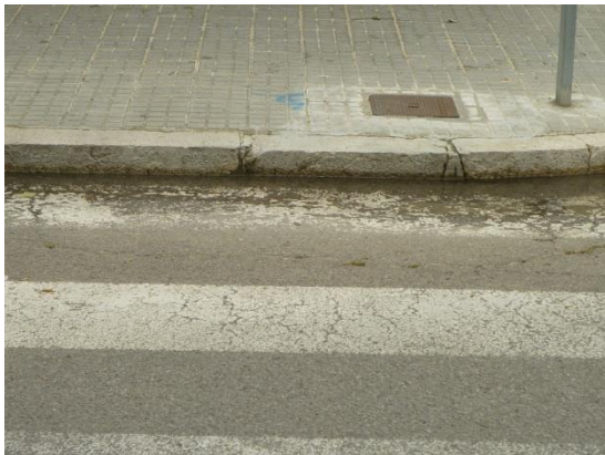
Imatge 63. Pas per travessar el c. Narcís Bardají. Calen mesures de supressió de barreres (rampa o gual).
