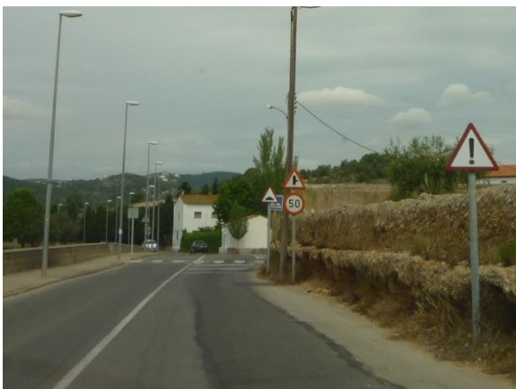
Imatge 9. S'ha d'evitar un excés de senyals consecutives que es tapin mútuament, ja que resulten invisibles per als conductors. Exemple de la carretera de Mas Trader.
