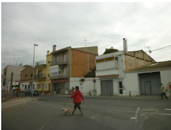
Imatge 5. Carrer Raval del Torrent, arribant a la plaça del Mercat. La senyalització de la cruïlla està pràcticament esborrada, dificultant la comprensió de l'espai, i deixant una obertura excessiva que comporta moviments poc segurs. A més el pas de vianants està excessivament endarrerits, i es produeixen creuaments fora de pas, resseguint l'itinerari natural marcat per les voreres.
