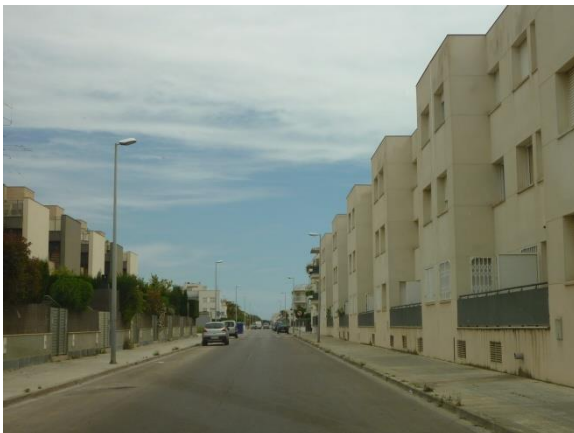
Imatge 83. Vista del tram amb secció indeterminada.
