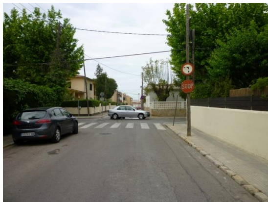
Imatge 59. Aproximació a la cruïlla per c. Ciutat de Barcelona. Doble sentit. Senyals que cal renovar.
