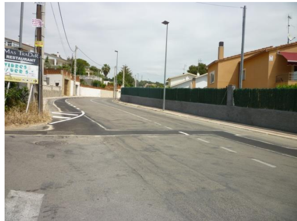
Imatge 68. Exemple d'orella pintada, sense necessitat de fer una actuació d'obra (a curt termini). Carrer Dàlia, a Mas Trader I.
