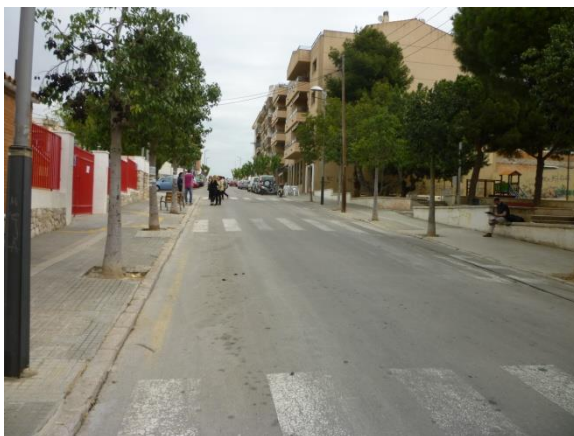
Imatge 104. Vista del tram amb 3 passos, davant del parc. Escàs ampli de vorera.
