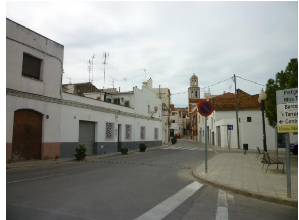
Imatge 34. Bandes reductores prefabricades al carrer Nou.
