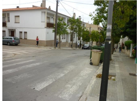
Imatge 103. Pas de vianants amb contenidors previs. Manca d'un pas a l'altre costat de la cruïlla.
