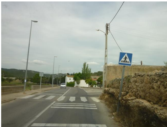
Imatge 35. Pas elevat a la carretera de Mas Trader.
