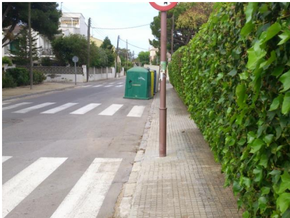
Imatge 15. Carrer Ciutat de Barcelona. La vorera és inaccessible degut a l'incorrecta localització d'un senyal de trànsit. A més, la vegetació envaeix part de l'espai de vorera. Aquest tram és intransitable.
