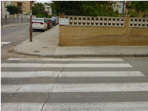
Imatge 11. Gual no adaptat on es manté el graó de la vorera al pas de vianants (exemple al carrer Dàrius Huguet).
